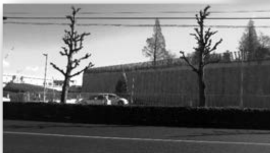
建設中の校舎
